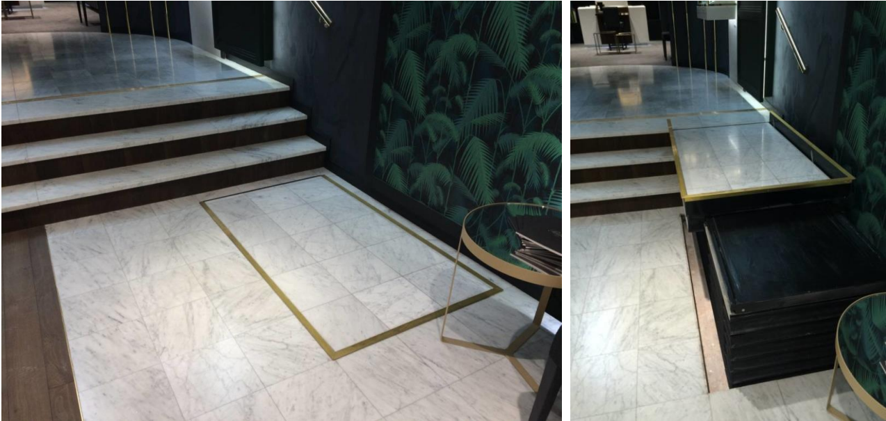
Figura 4 - Esempio di piattaforma traslante a scomparsa nella pavimentazione
